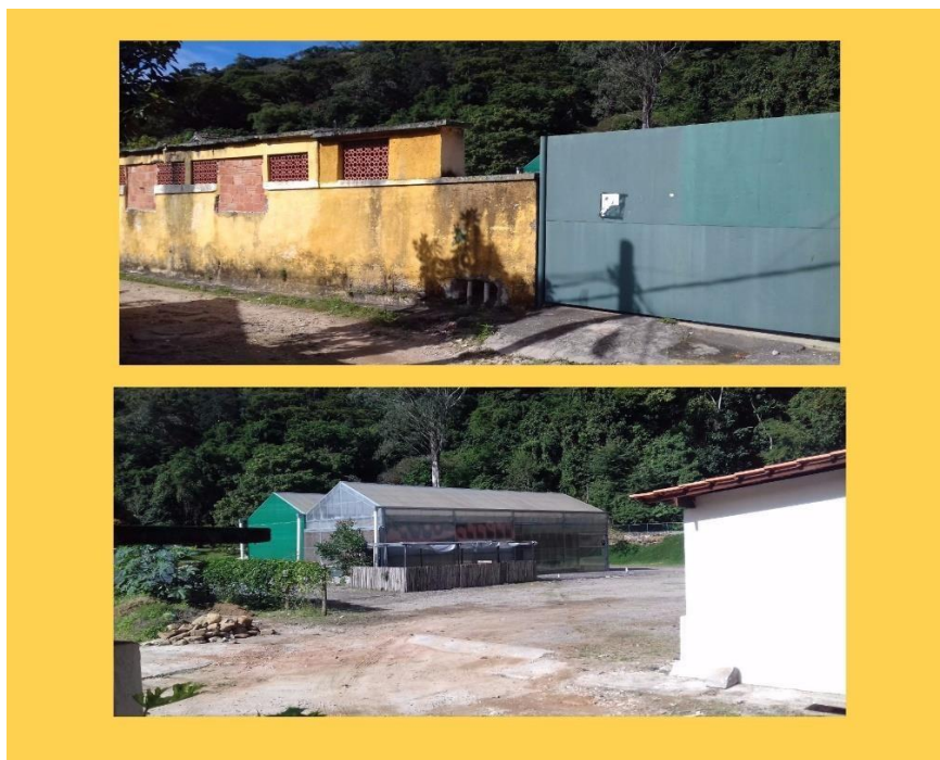
Figura 15 - Estufa construída onde funcionava o Clube Caxinguelê. Fonte: Arquivo Pessoal cedido por Samuel Georgius.
