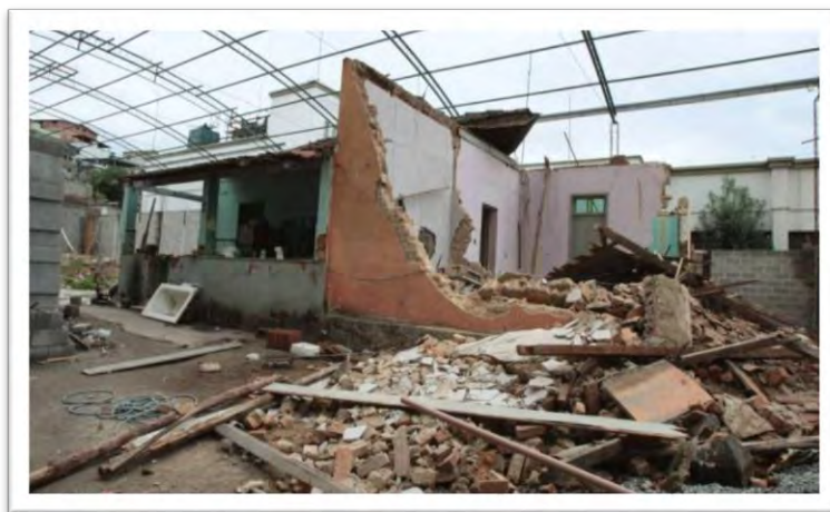
Foto 9 - Imagem retirada da notícia - Casa demolida
